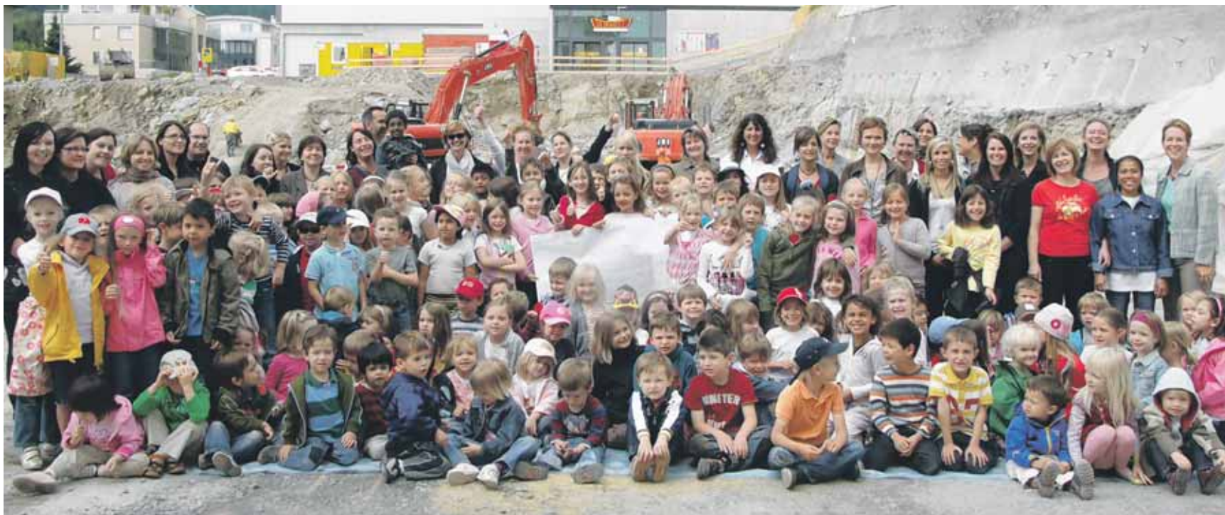
Rund 160 Kinder der Obersee Bilingual School schauten sich am Freitag die Baugrube für das neue Schulgebäude an.
